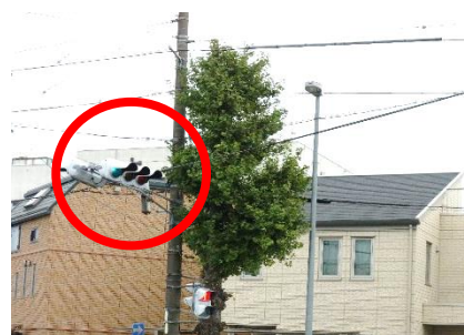
写真 2-6 信号機と接触しかけている樹木
