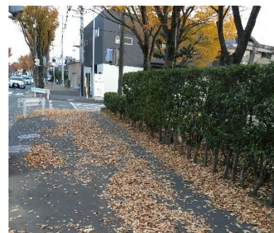
写真 2-8 落ち葉が吹きだまっている歩道
