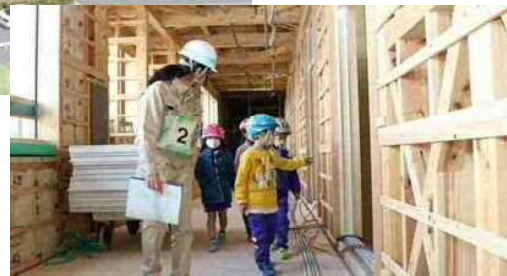
高根小学校 建設現場見学会の様子
