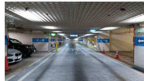
松葉公園地下駐車場
