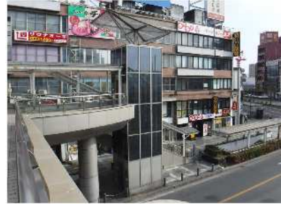
東口ペDESTリアンデッキ エレベーター
