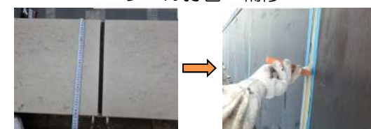
シール打替・補修
