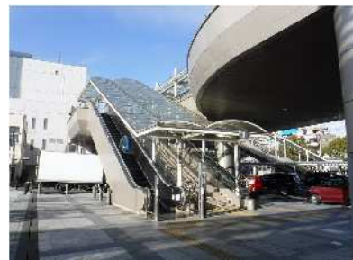
東口ペDESTリアンデッキ エスカレーター
