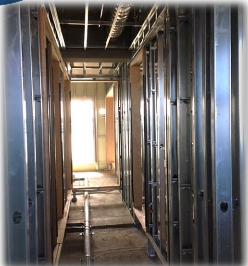
内壁の下地(軽量鉄骨)がむき出しの様子。
