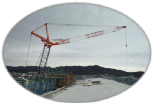
コンクリート打設は屋根まで完了しました。
