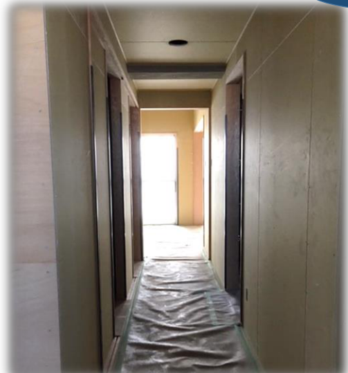
内壁の下地にボードを貼った様子。
