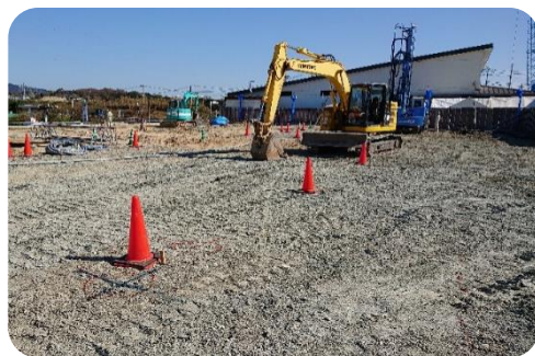
10月時点の工事現場の様子
