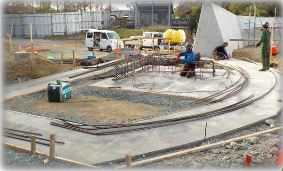
11月中旬ごろの様子。 コンクリートの中に埋める、基礎鉄筋を組み立てています。
