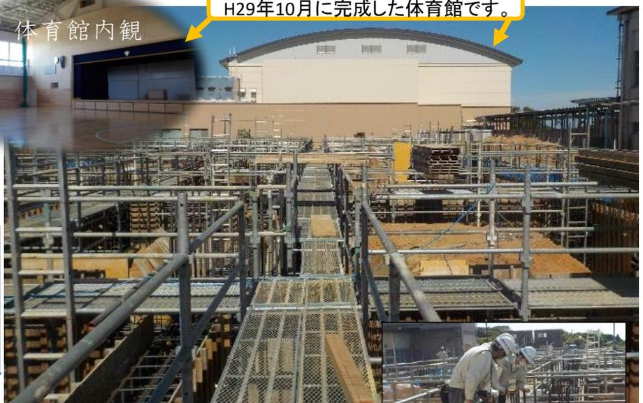
コンクリート打設前に、設計通り鉄筋が入っているか検査をしています。
