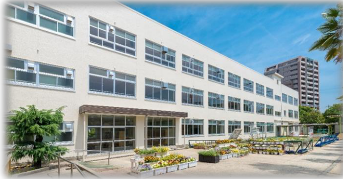
松葉小学校 外観 外壁を塗り直し、きれいな校舎に生まれ変わりました!
