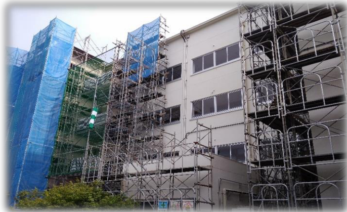
石巻中学校 外観(工事中) まだ足場が設置されていますが、外壁はきれいになっています。
