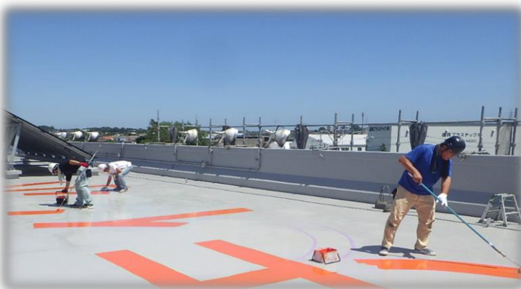
天伯小学校(工事中) ヘリコプターからの災害活動を円滑に行うため、屋上に学校名を書いています。
