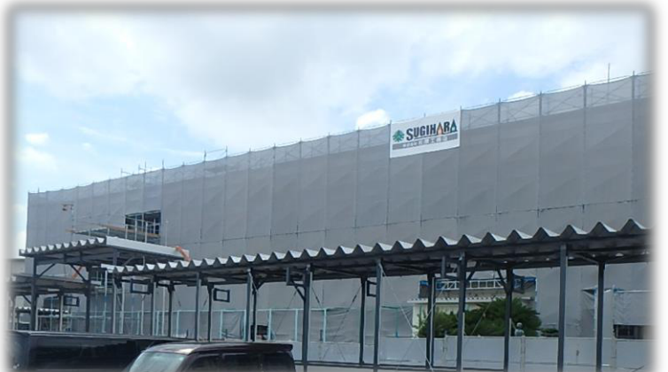
津田小学校 外観(工事中) 校舎はまだ足場で覆われています。
