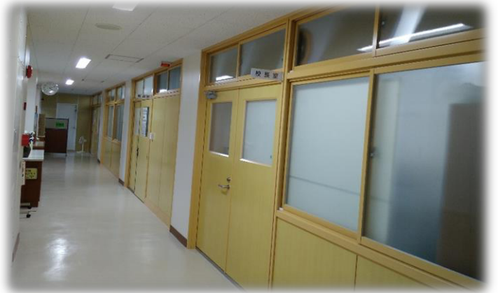
石巻中学校 校長室・職員室前廊下(完成) 白い床は清潔感があり、黄色い建具が際立ちます。
