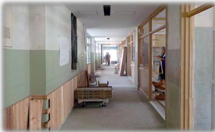
津田小学校 廊下(工事中) 現在、内装の工事をしています。
