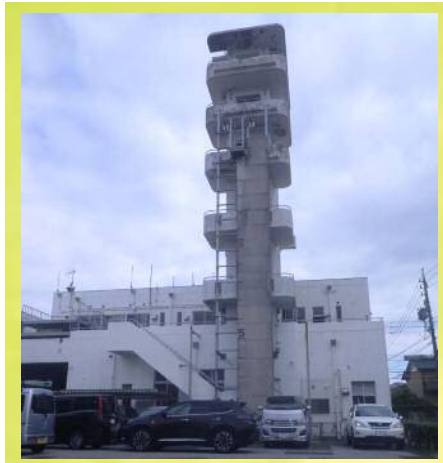
火見塔解体前
