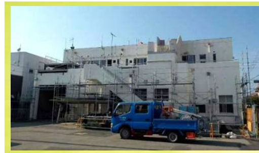
火見塔解体後
