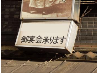
屋外広告物本体の傾き
