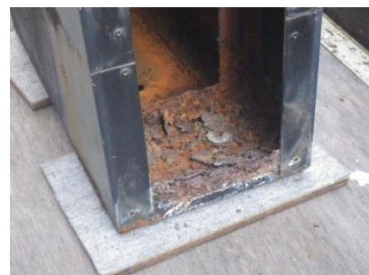
底部が腐食していた看板の例
