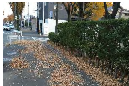
写真 2-8 落ち葉が吹きだまっている歩道
