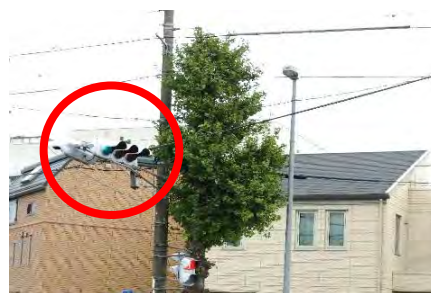
写真 2-6 信号機と接触しかけている街路樹
