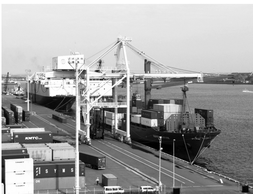
「ガントリークレーン」
