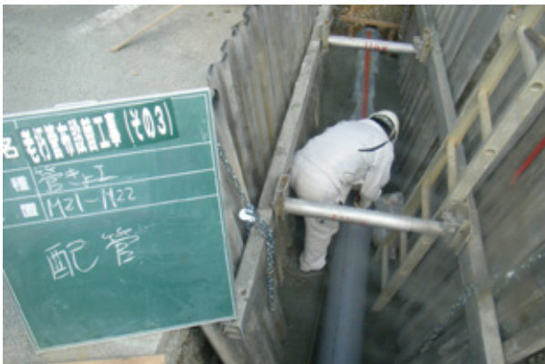
古くなった污水管を取り替えているところ 【老朽管布設替工事】
