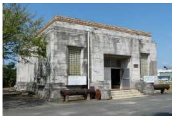
図 2-4 豊橋市上水道施設小鷹野浄水場旧ポンプ室
