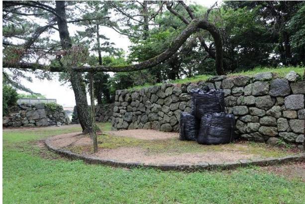
孕み出しを大型土嚢で抑える石垣（本丸北）
