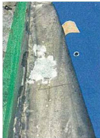
梁上に残っているアスベスト含有吹付け材は、固化し隔離用ポリシートで養生した上から、屋根面全体を隔離用ポリシートで覆いし、さらにブルーシートを2枚張りして風で飛散しないように補強しています。
