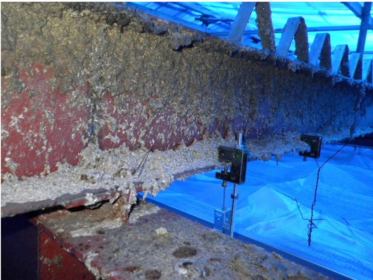
鉄骨梁面残存アスベスト状況(1)
