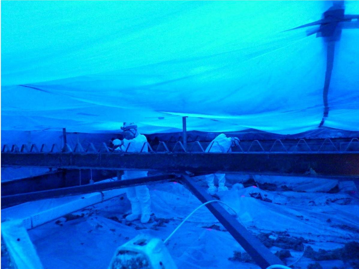
鉄骨梁面残存アスベスト除去状況
