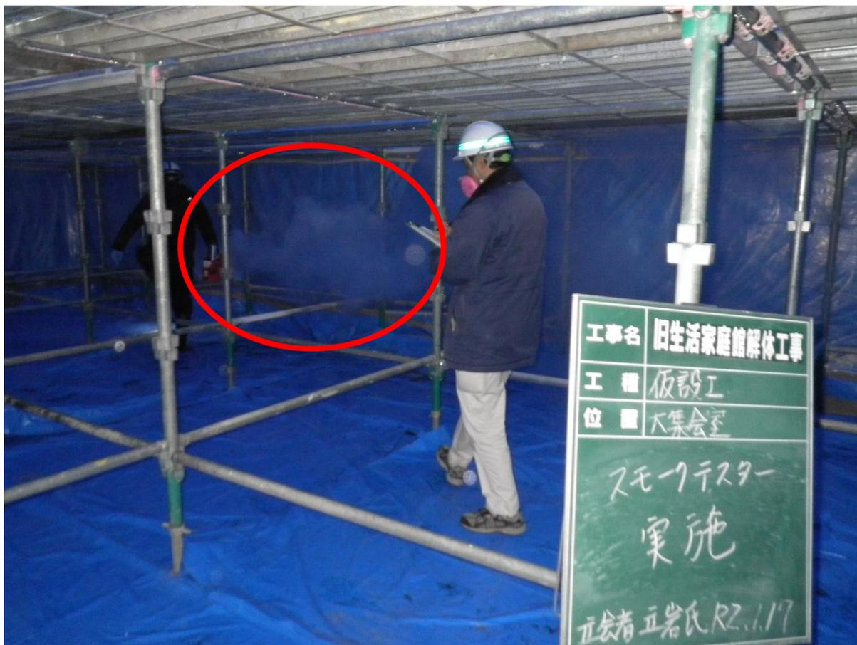
スモークマシンによる作業場内の気密試験(1)
