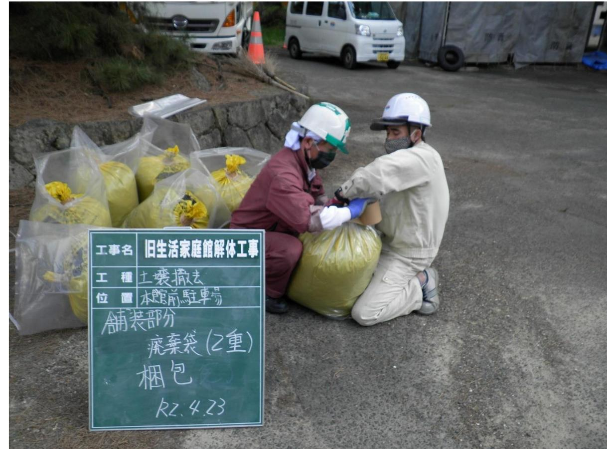
(アスベスト含有土壌除去(運搬経路・アスファルト舗装部分)R2.4.23)
