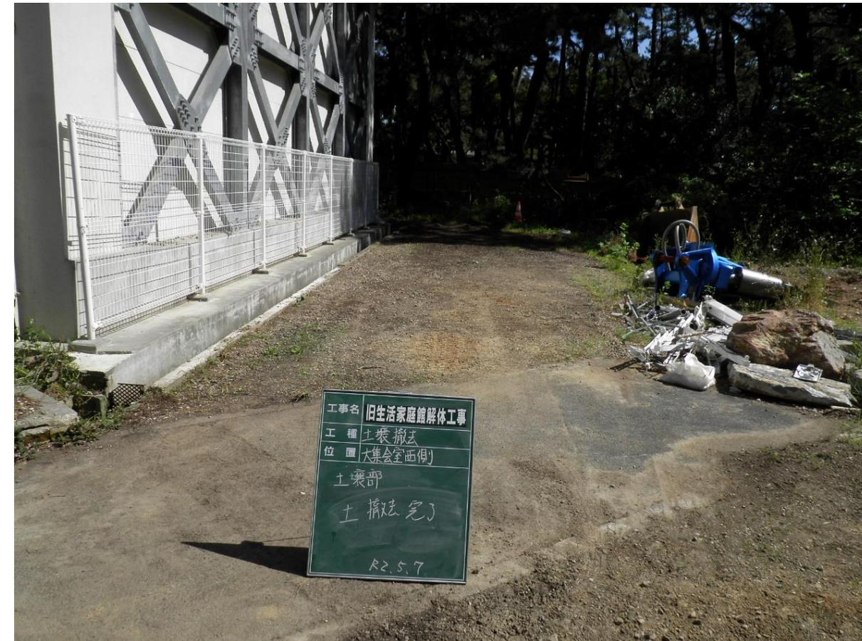
(アスベスト含有土壌除去(土壌撤去完了・土壌保管状況)R2.5.11)
