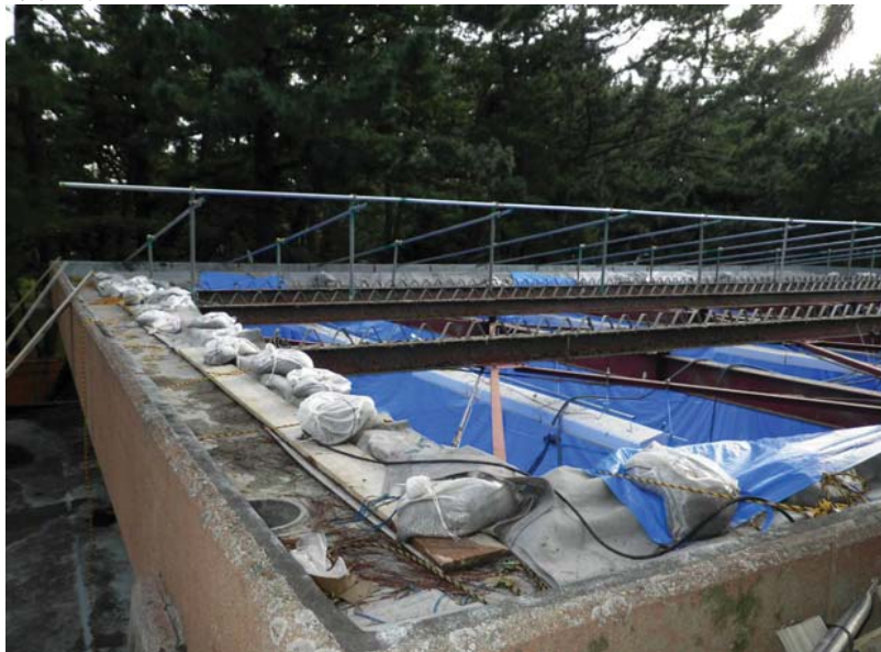
大集会室の仮設屋根骨組施工中
