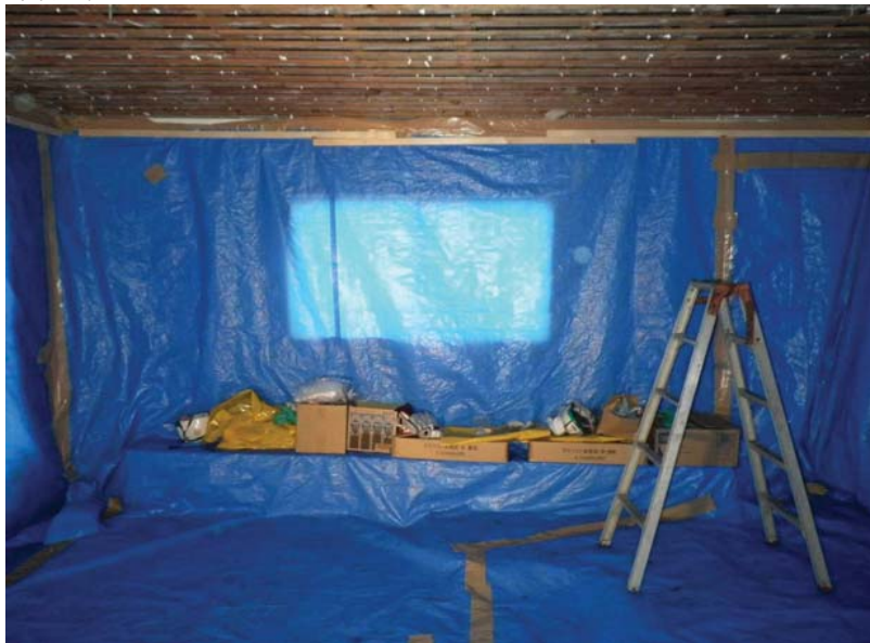
大集会室玄関内部のブルーシート養生
