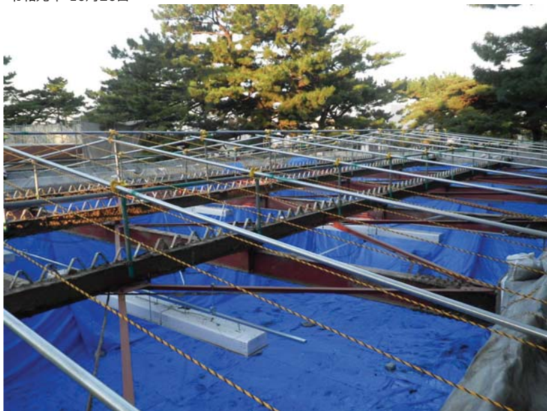
仮設屋根骨組完成
