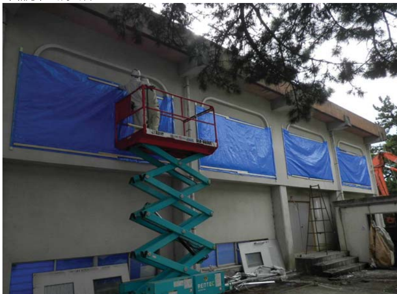
外部窓開口部にポリシート+ブルーシート貼り施工中
