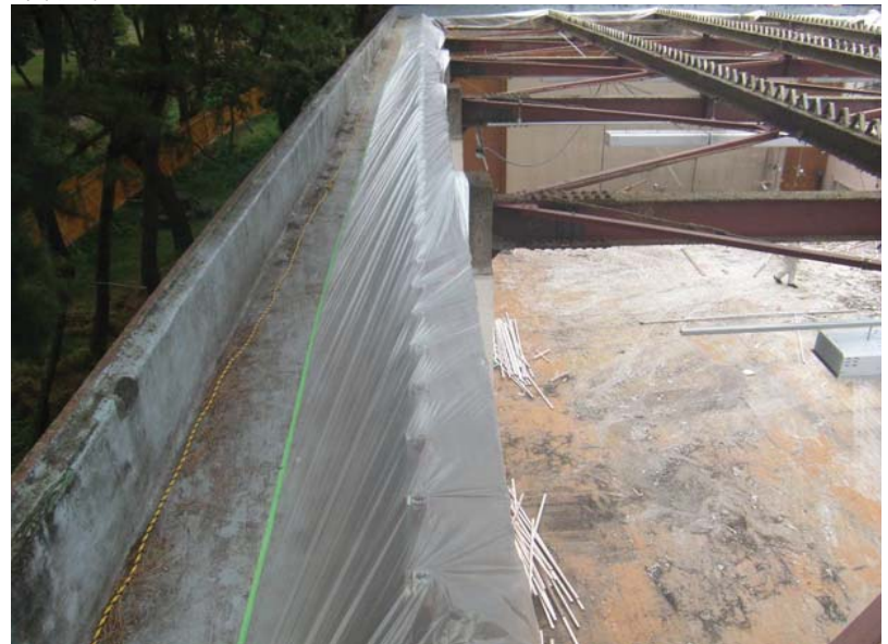
応急措置（固化剤で固めたアスベストを養生シートで保護）
