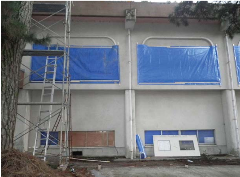
大集会室外部窓開口部をポリシート+ブルーシートで覆う
