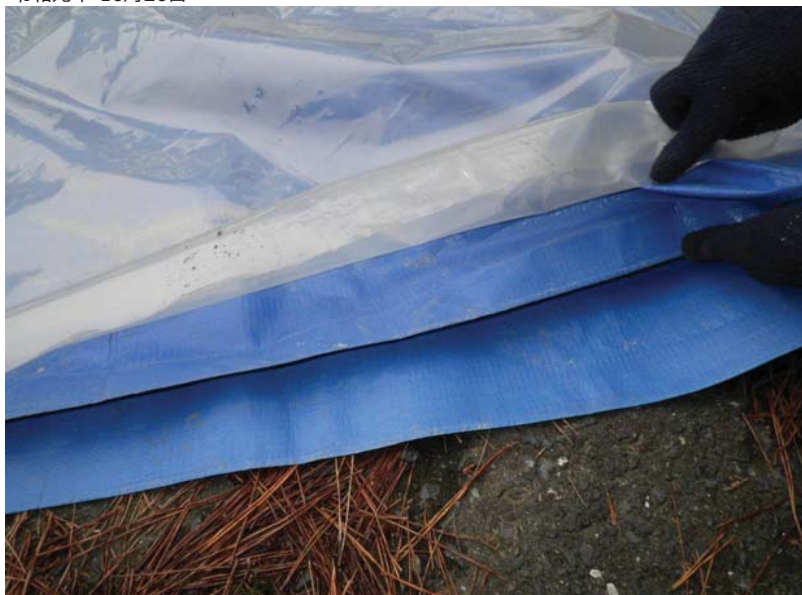
隔離用ポリシート (0.15mm) + ブルーシート
