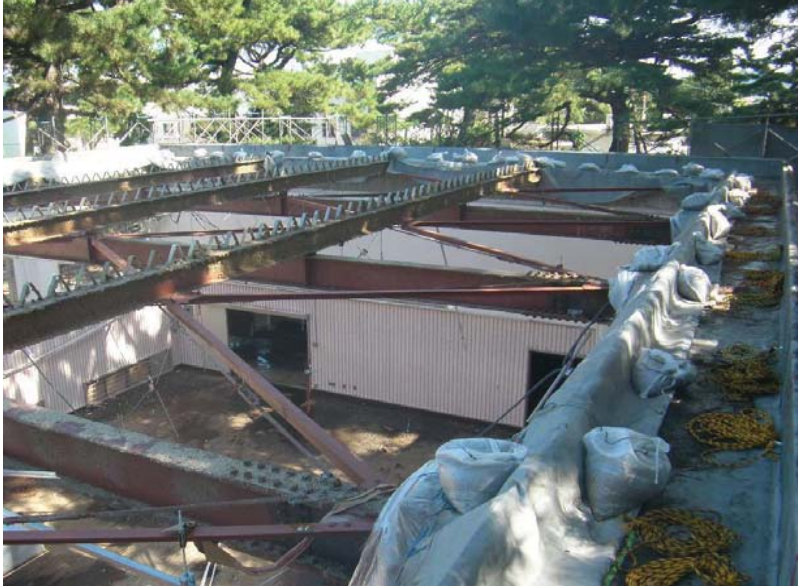
再度養生テープで保護し、防音シート（厚手のシート）で覆った
