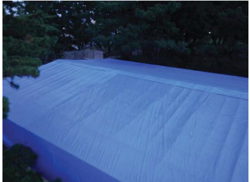
仮設屋根 2層目 ブルーシート
