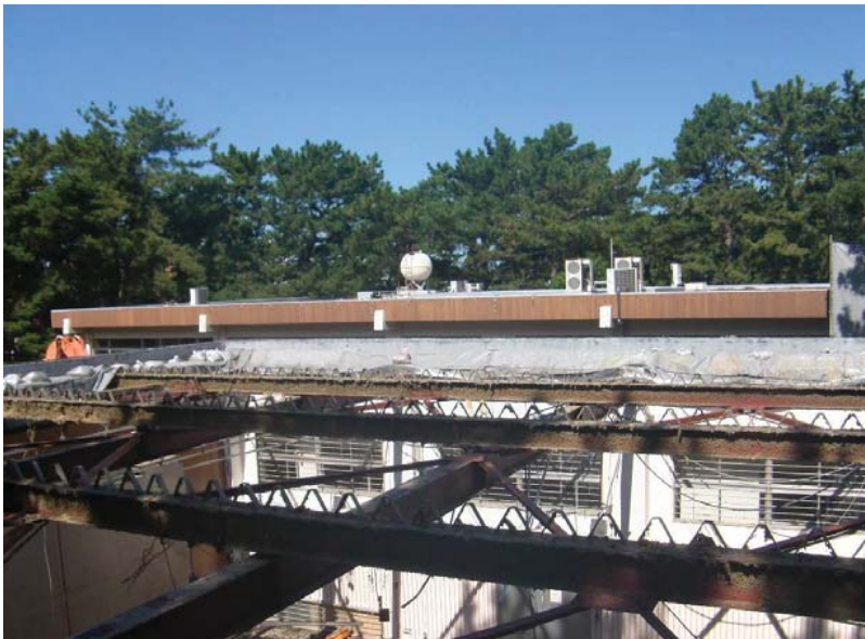
再度養生テープで保護し、防音シート（厚手のシート）で覆った
