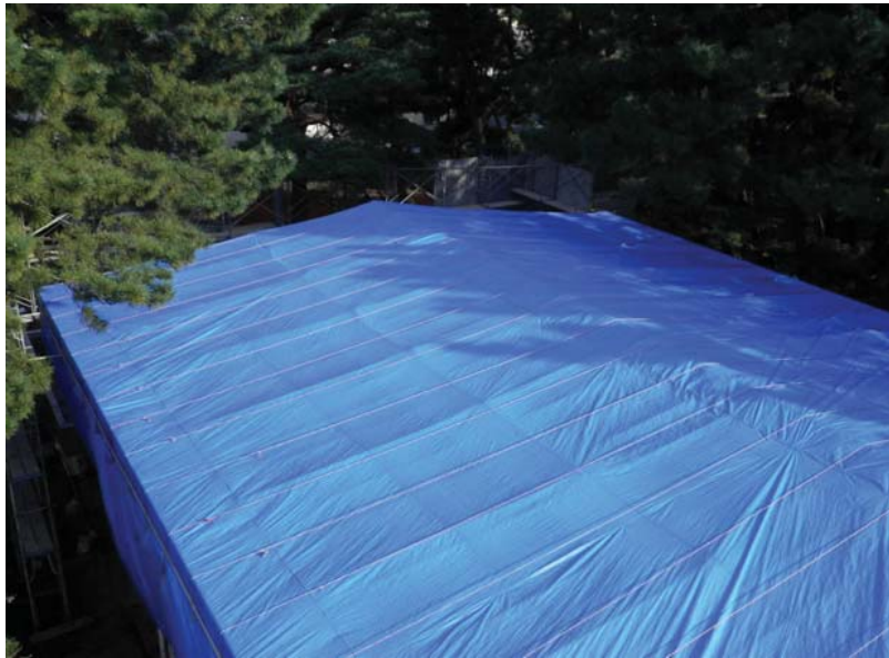
仮設屋根3層目 ブルーシート
