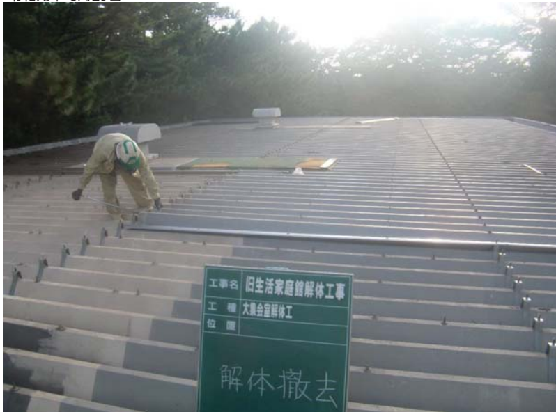
カバー折板（H15年の屋根改修で貼った金属屋根）を剥がしている作業状況
