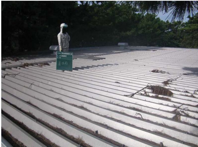
解体作業前の屋根の状態
