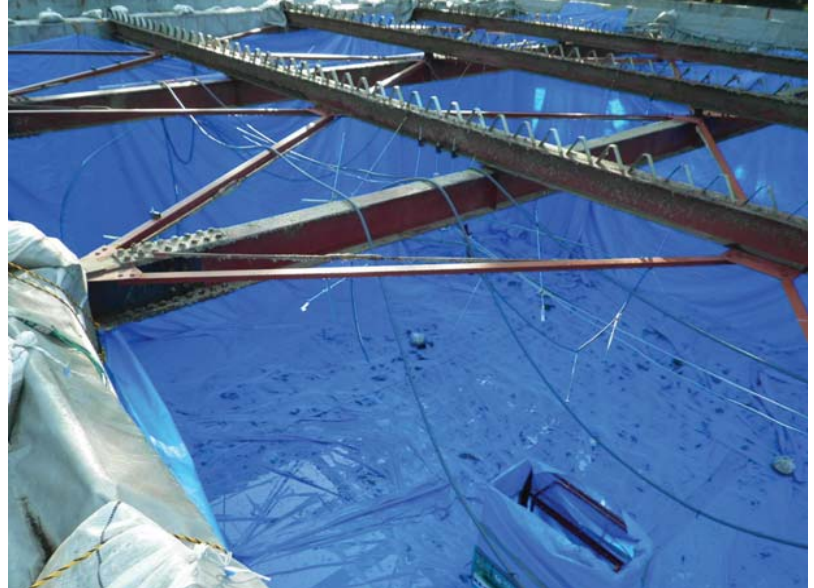
大集会室内部（床・壁）をブルーシートで養生
