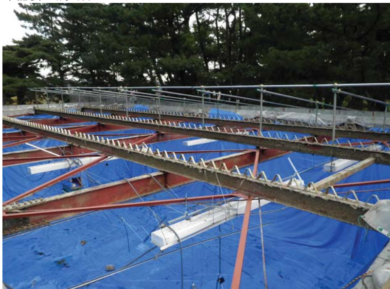
大集会室の仮設屋根骨組施工中
