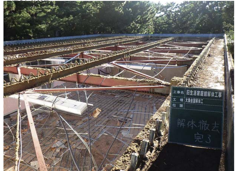
折板（当初からあった下の金属屋根）が全て撤去された状況
