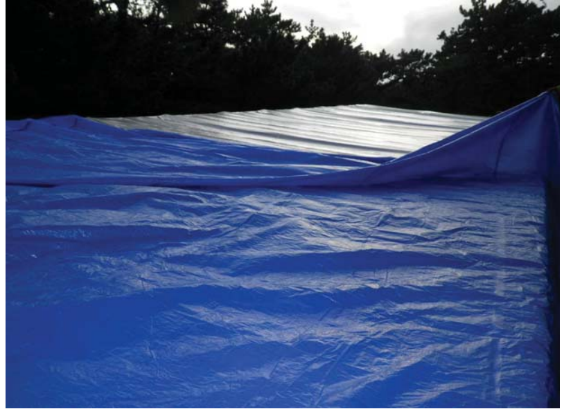
仮設屋根 1層目 ポリシート (0.15mm)
