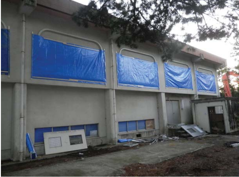
大集会室外部窓開口部をポリシート+ブルーシートで覆う
