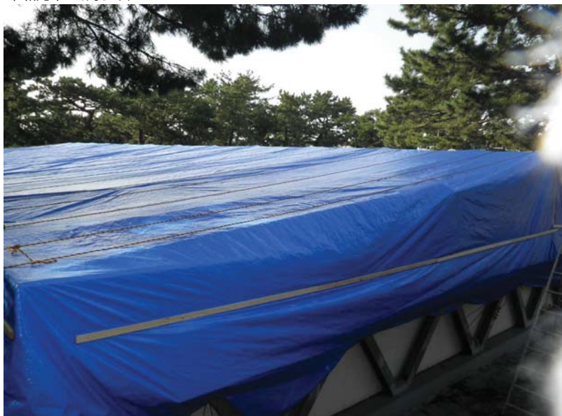
仮設屋根完成
