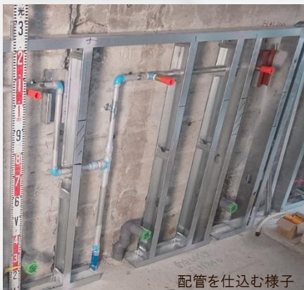
配管を仕込む様子
