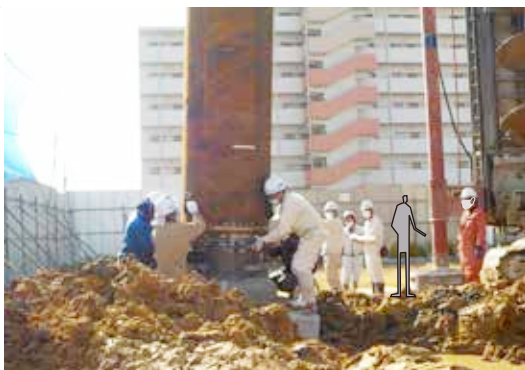
杭は金具で結合させ10m程の長さになります。
