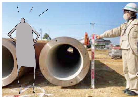
こんなに大きな杭が建築物を支えます。
