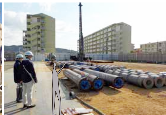
既製杭『プレボーリング拡大根固め工法』。
