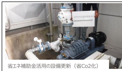
設備工事(ライフラインの整備・提供)
