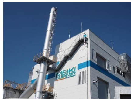
○焼却発電施設「カグツチ」
