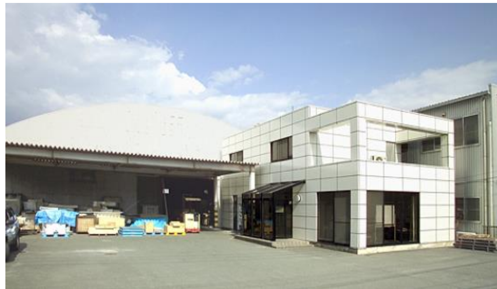
様々な建材をストックしている豊橋営業所
