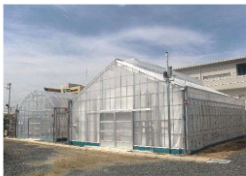
【完成したビニールハウス】
