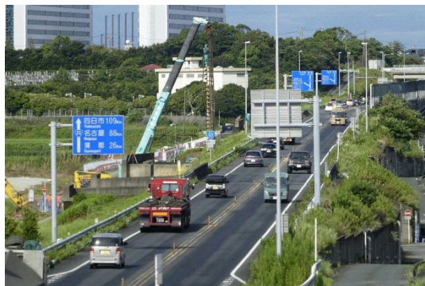
4車線化の整備を進める名豊道路 （国道23号バイパス）
