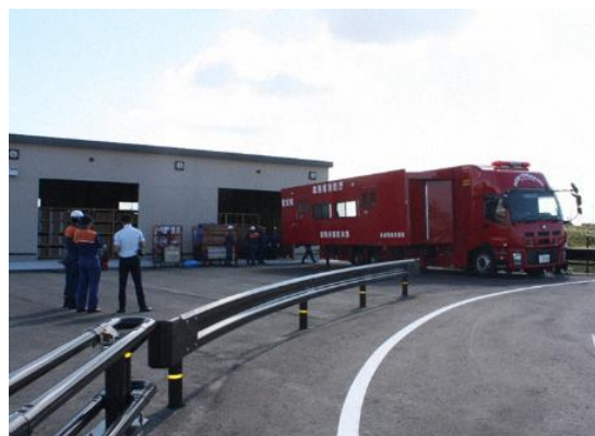
道の駅「とよはし」の防災備蓄倉庫
