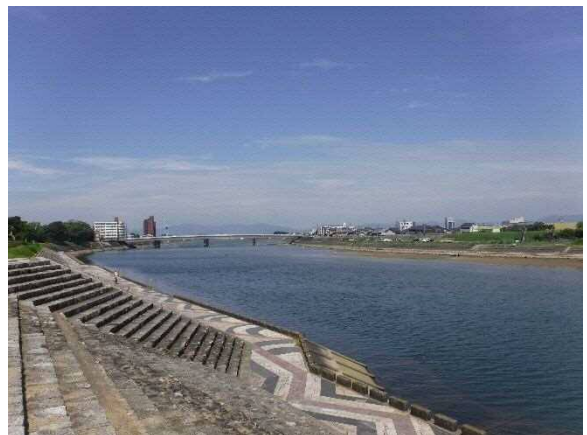
豊川下流域 吉田大橋付近 護岸
