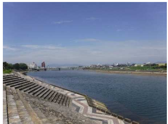
豊川下流域 吉田大橋付近 護岸
