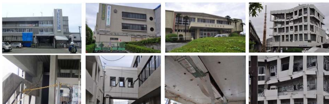
大津町役場の被害 益城町役場の被害 益城町体育館の被害 宇土市役所の被害
