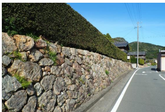
防風や水防のために設けられた外構。地域で採れる石材や地域の環境に適した木が使われている。
