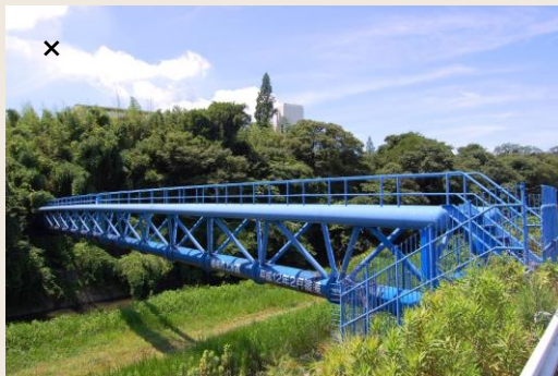
改善前の青い水管橋
