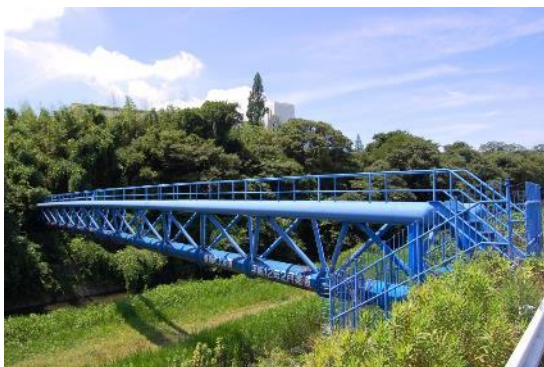
■ 改善前の水管橋（上下水道局前）
