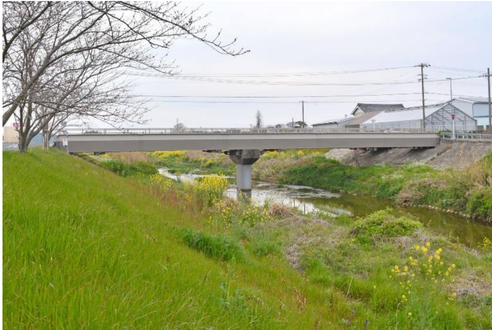
■桁高が高い歩道橋の塗装例：横断歩道橋の色彩基準に準じた2色の配色で、スリムに見えるように配慮している。背景が堤防になるため、横断歩道橋の基準より明度を下げた色彩を選択している。(上部 10YR6.5/1 下部 10YR5/1)
