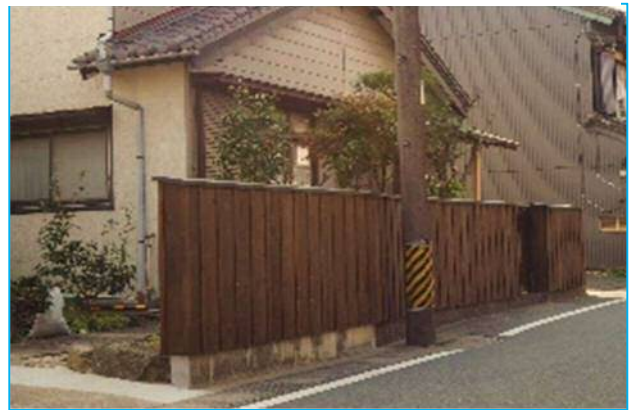
▲ブロック塀を改修し、こげ茶色の板塀としました。
