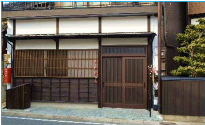
▲正面の外壁を伝統的なデザインに改修し、窓には木製の格子を取り付けました。
