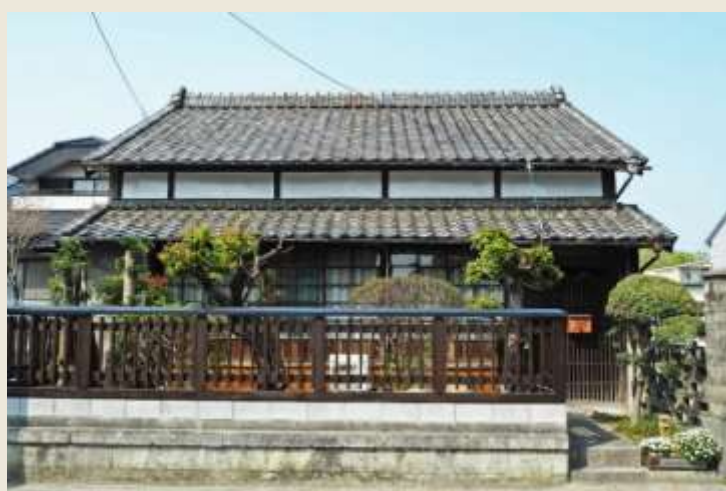
▲ 整備後：劣化した外壁を改修し、街道に沿って木製の格子塀を設置。塀と庭木の向こうに切妻平入の趣のある家が見えるようになった。玄関の繊細な格子戸や縁側のガラス戸が美しく懐かしい。
