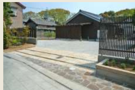
▲ 整備後：和風の板塀と格子を設け、乗り入れを自然石で仕上げ、趣ある空間を創出した。
