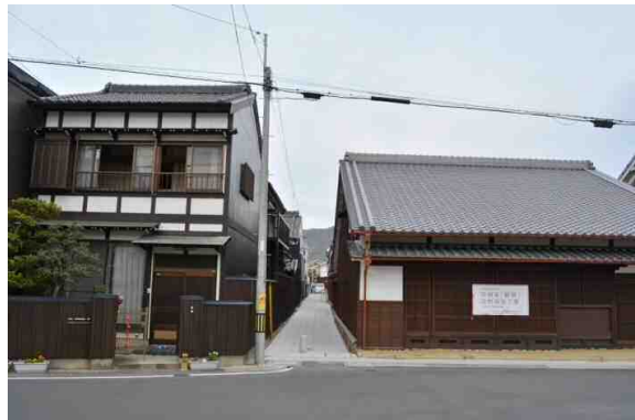
▲旧街道から瀬古道を望む (左：景観整備した安田邸 右：文化財「駒屋」)
