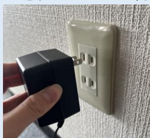
コンセント側
