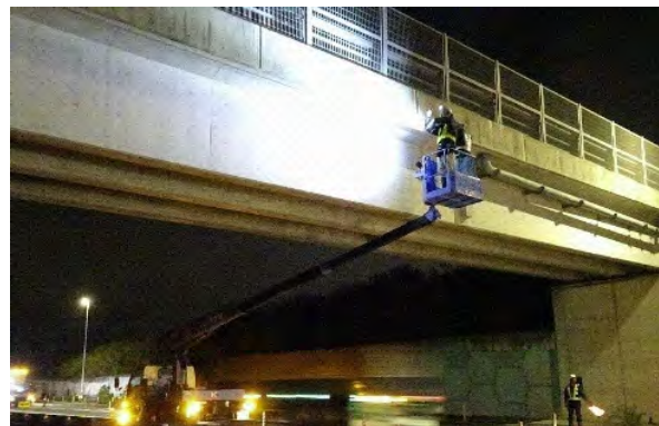
長寿命化計画に基づく橋りょうの点検
