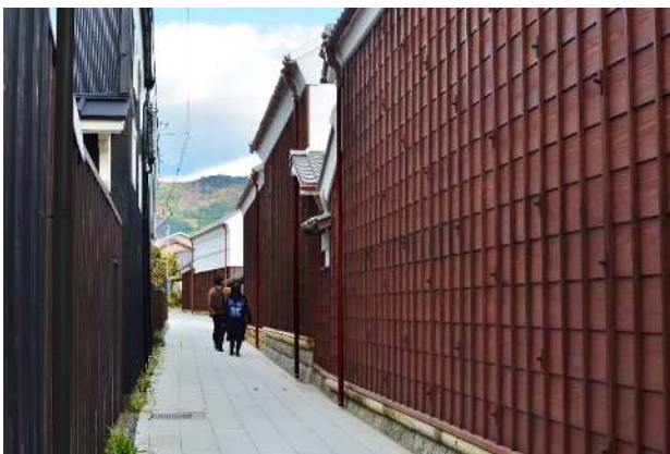
▲ 商家「駒屋」と瀬古道：右側の建物が駒屋（南から北を望む）
