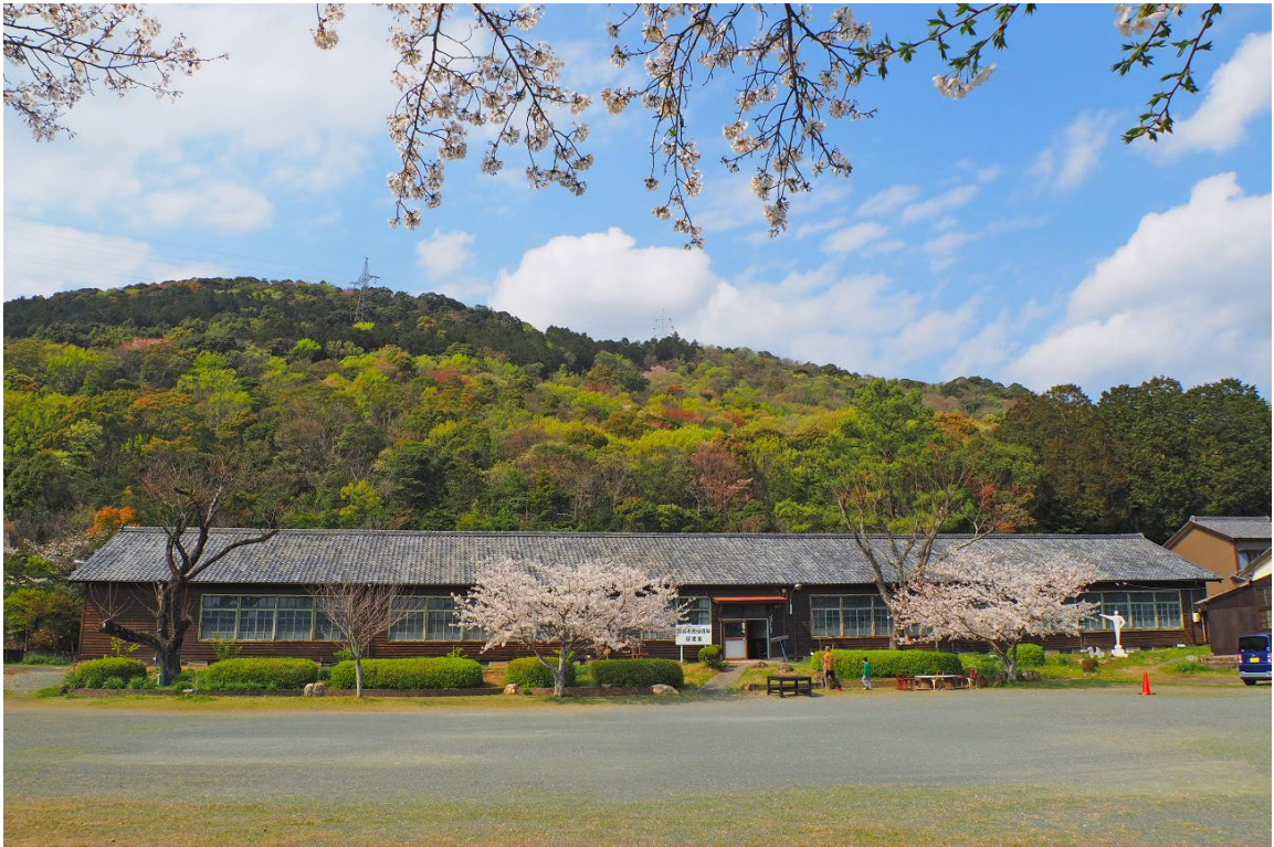
▲ 多米民俗資料収蔵室本棟（旧多米小学校本校舎）：全景 南から望む
