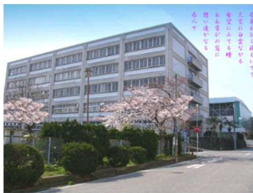
【豊橋市立豊橋高等学校の校舎】
