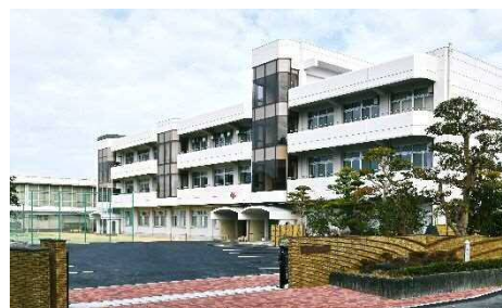
【豊橋市立家政高等専修学校の校舎】
