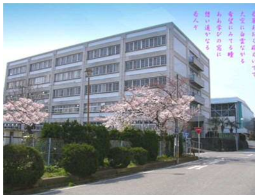
豊橋市立豊橋高等学校の校舎
