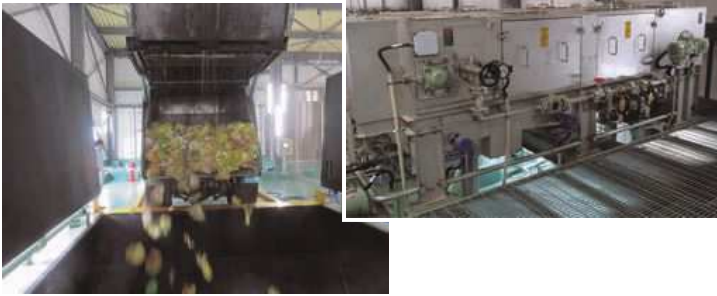
生ごみピット
