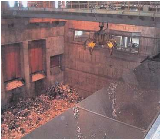
ごみピットの様子
