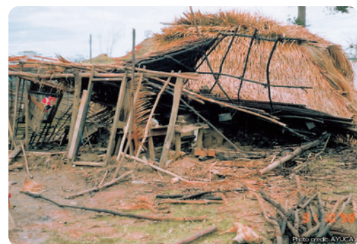
グアテマラのハリケーンで倒壊した家
