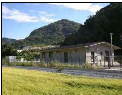
高山浄化センター
