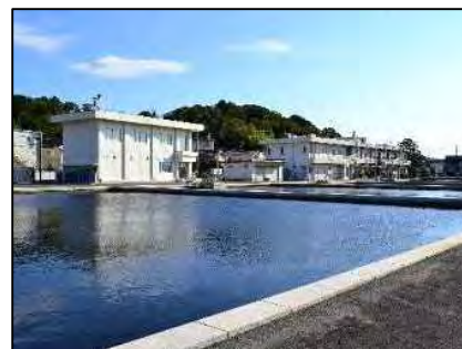
小鷹野浄水場
