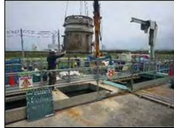
【老朽化した処理場の改築工事】
