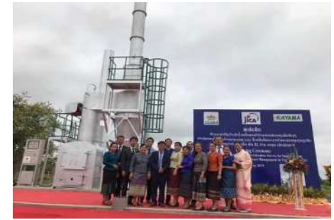
○ラオス国焼却炉設備
