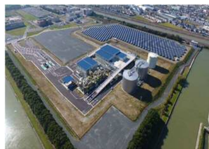
写真 2-3 バイオマス利活用センター （PFI 事業）
