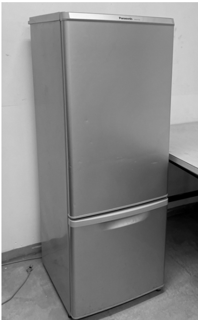
【図表 4－Ⅱ 7－5】豊橋球場建物内に設置された冷蔵庫
