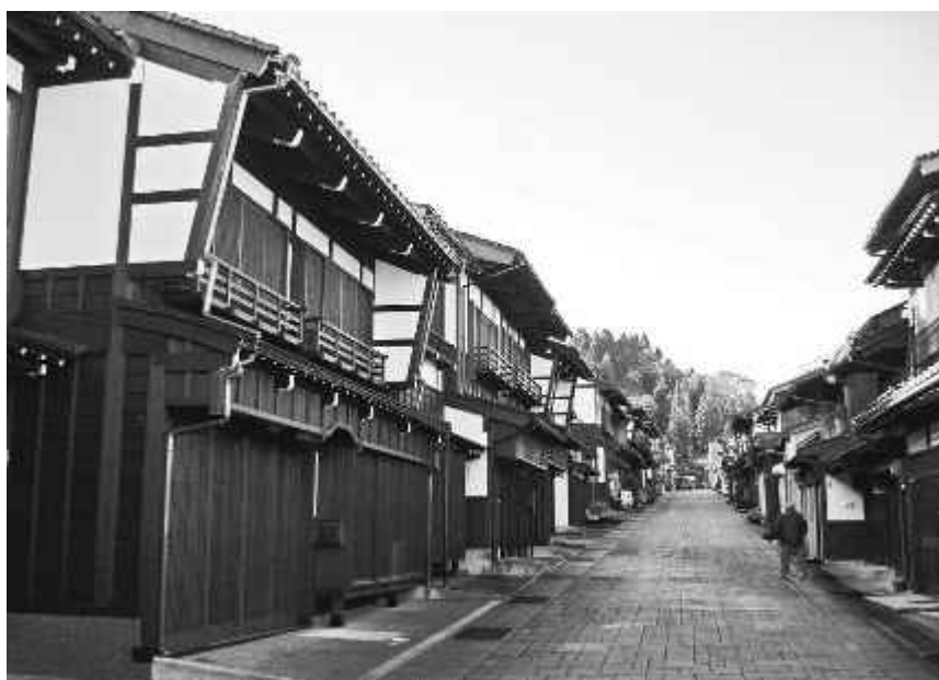
【図表 4 - II 9 -17】 諏訪町本通り
