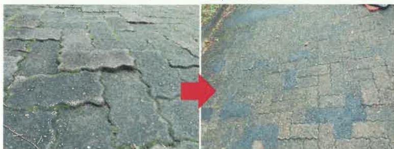
スロープ修繕
