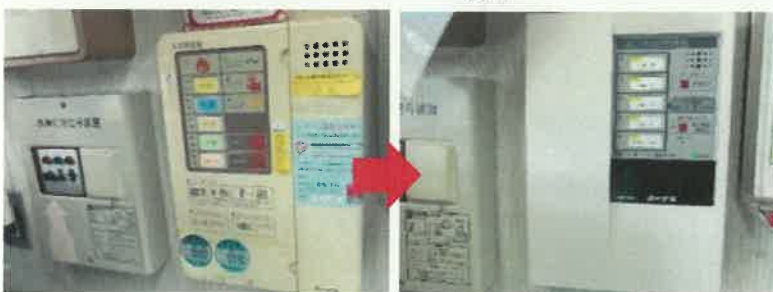
自動火災設備交換
