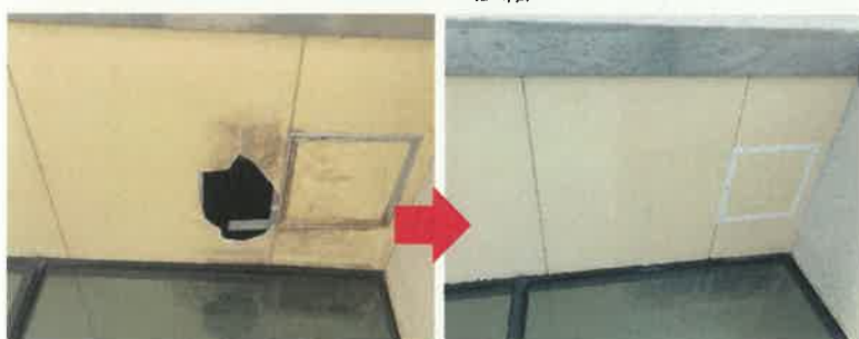
2階ベランダ天井修繕
